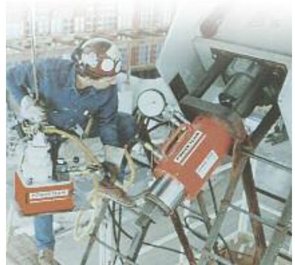
Bomba PA554 y cilindro RH2008 de orificio central usados para tensar cables.
