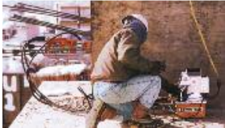
Modelo PE60 usado para una aplicación de pretensado
